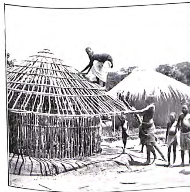
Costruzione di una casa.
